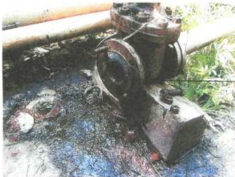
Fig. 18 Se puede apreciar presencia de parafina en la válvula a la entrada de los tubos testigo del pozo Lis-54.
