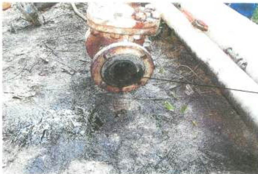
Fig. 17 Se puede apreciar presencia de parafina en la válvula ubicada a la salida de los tubos testigos del pozo Lis-54.
